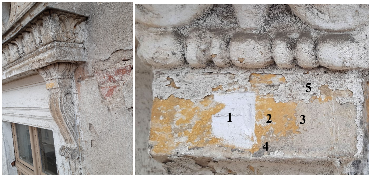
fot 69. Detale wokół okna na elewacji zachodniej – A zaznaczone miejsce wykonania odkrywki i pobrania próbki; B – odkrywka – wspornik wykonano z gipsu (kolor biały) i pomalowano na żółto.
