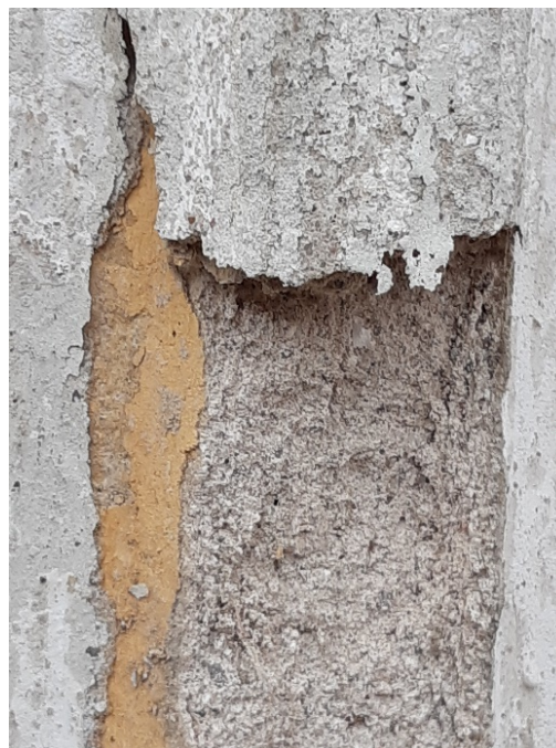
fot 66. Odsłonięty kolor na kanelowaniu pilastra w ryzalicie na elewacji zachodniej.
