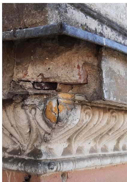
fot 61. Fragment z gzymsu na nowszej części budynku – odsłonięty historyczny kolor żółty.
