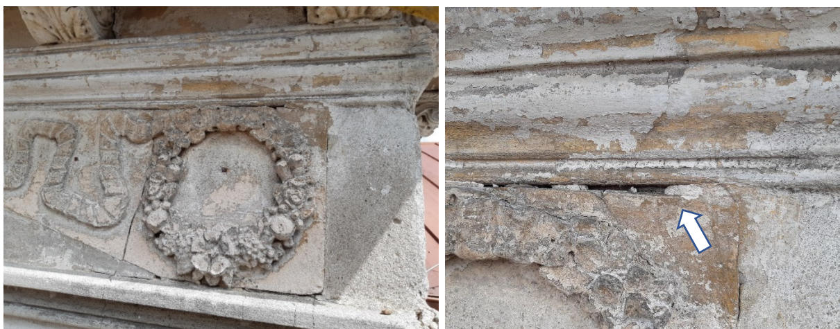
fot 34. Gzyms nad oknem w ryzalicie elewacji zachodniej – widoczne wykruszenia w miejscu wklejenia płyciny.
