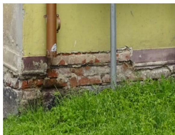
fot 11. Narożnik południowo-zachodni – ceglany cokół z uszkodzeniami tynku.
