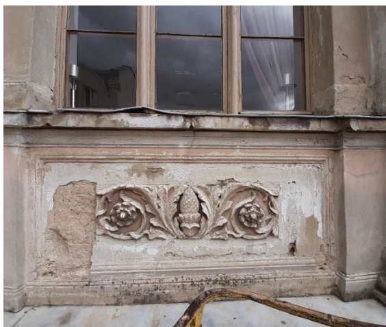
fot 77. Płycina pod oknem środkowym w ryzalicie od strony zachodniej – zaznaczone miejsca odkrywek i pobrania próbek
