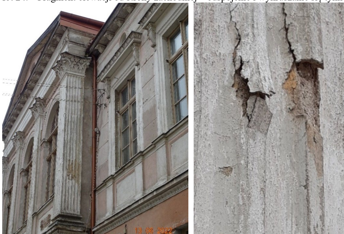
fot 25. A - Fragment ryzalitu od strony podwórza; B – widoczne zniszczenia kanelowania pilastrów.
