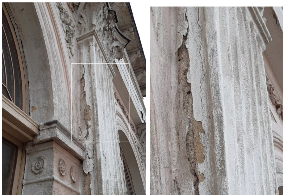
fot 24. Fragment elewacji od strony zachodniej – odspojenie i wykruszanie się tynków,
