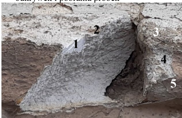
fot 78. Fragment gipsowego ornamentu z płyciny pod oknem środkowym w ryzalicie od strony zachodniej.
