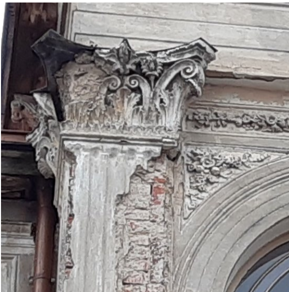
fot 33. Zniszczenia kapitelu w ryzalicie na elewacji zachodniej.
