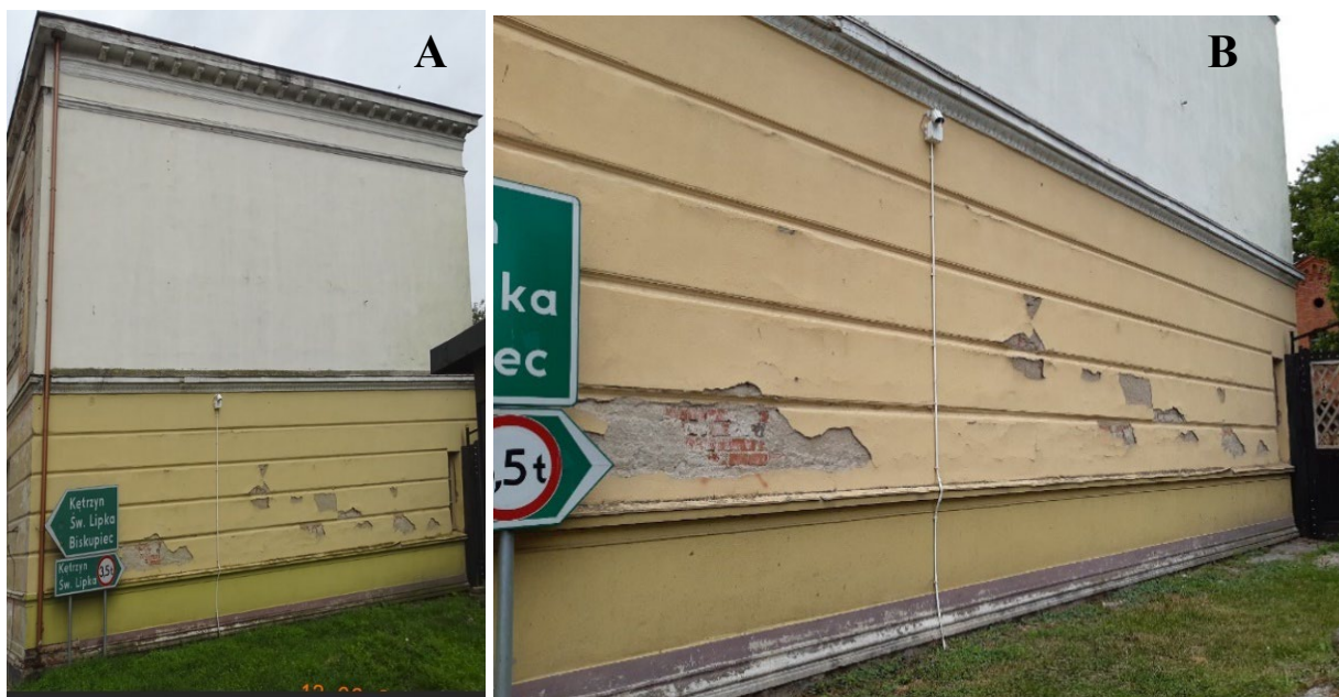
fot 5. A - Widok elewacji południowej; B – zniszczenia tynku kondygnacji parteru.
