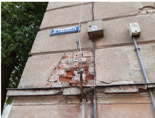
fot 18. Fragmenty elewacji zachodniej - zniszczenia tynków i zamontowane instalacje.
