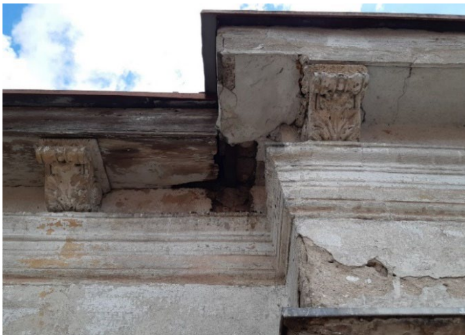
fot 39. Elewacja zachodnia, miejsce łączenia dwóch części budynku – widoczne uszkodzenia gzymsu i okapu dachu.
