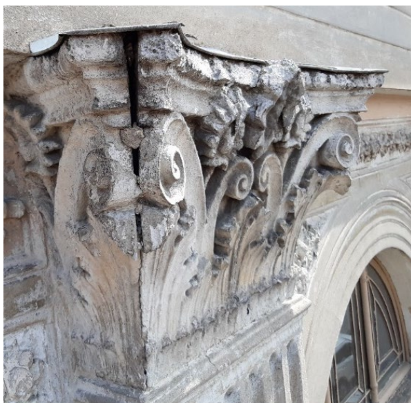
fot 33. Zniszczenia kapitelu w ryzalicie na elewacji zachodniej.
