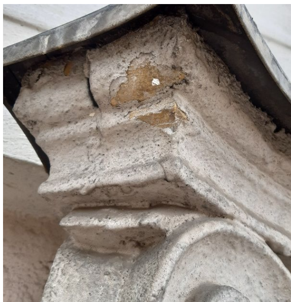
fot 59. Odkrywka na gzymsie nad kapitelem – ryzalit na elewacji zachodniej.
