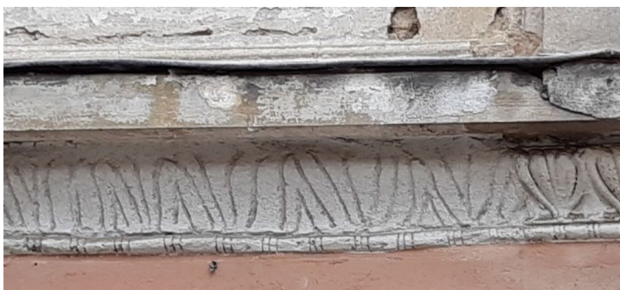
fot 38. Przykłady detali fryzu pod gzymsem międzykondygnacyjnym, po niefachowym uzupełnieniu – elewacja zachodnia
