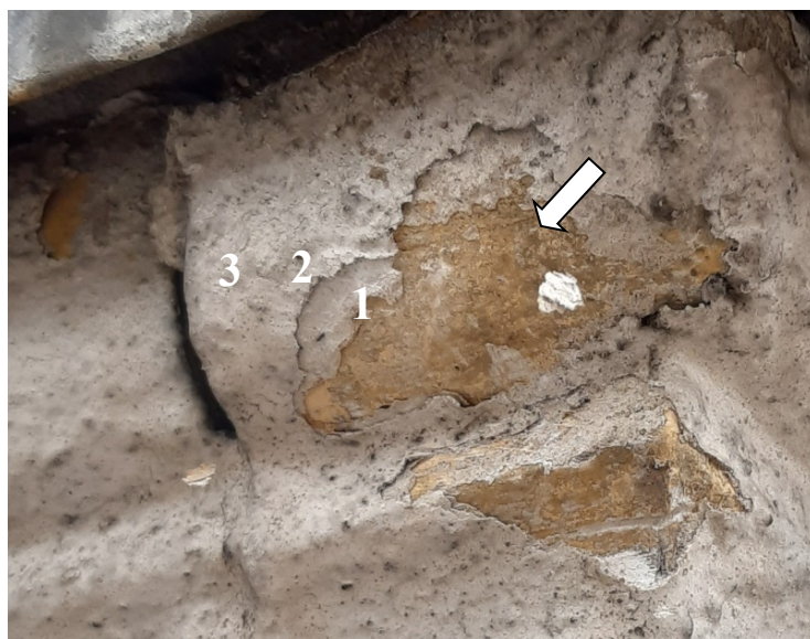
fot 59. Odkrywka na gzymsie nad kapitelem – ryzalit na elewacji zachodniej.
