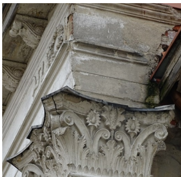
fot 31. Kapitel i gzyms koronujący na elewacji zachodniej od podwórza – widoczne uszkodzenia tynków.
