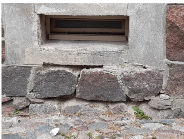
fot 9. Cokół elewacji od strony zachodniej – wykruszone spoiny i mniejsze kamienie (A); instalacje przymocowane do cokołu (B)
