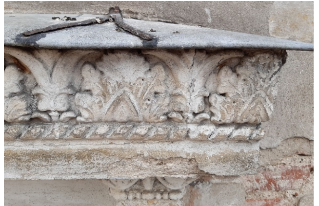
fot 16. Daszek nad gzymsem nadokiennym na elewacji zachodniej
