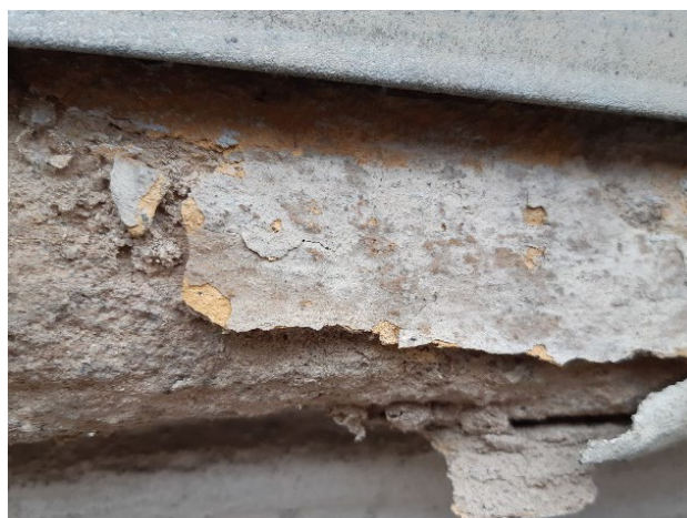
fot 27. Stan gzysu podokiennego w ryzalicie od strony zachodniej – widoczne bardzo duże rozwarstwienie tynków.
