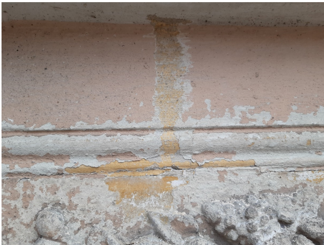
fot 58. Odkrywka pasowa na elewacji zachodniej.
