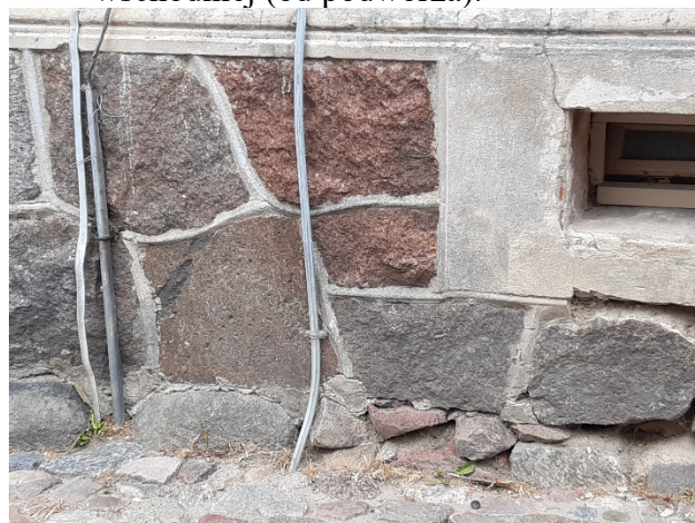
fot 9. Cokół elewacji od strony zachodniej – wykruszone spoiny i mniejsze kamienie (A); instalacje przymocowane do cokołu (B)
