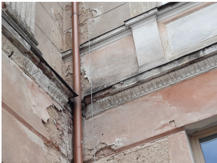
fot 12. Zniszczenia tynków w pobliżu rynny na elewacji od strony wschodniej (podwórzowej).
