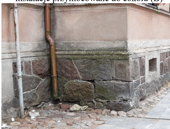
fot 10. Narożnik na ryzalicie od strony zachodniej – zazielenienie powierzchni elewacji w pobliżu rynny.
