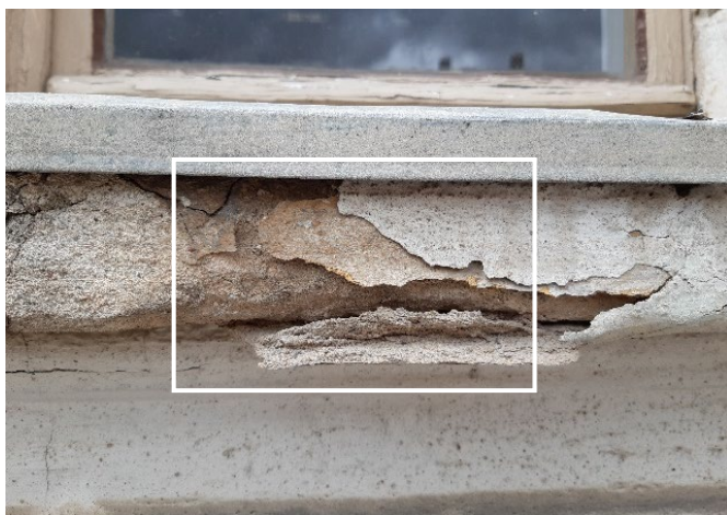
fot 27. Stan gzysu podokiennego w ryzalicie od strony zachodniej – widoczne bardzo duże rozwarstwienie tynków.
