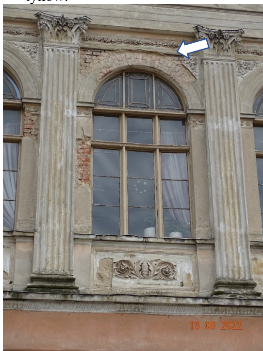
fot 23. Uszkodzenia wypraw wokół okna – elewacja zachodnia.
