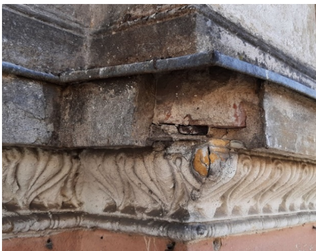
fot 28. Gzyms na elewacji od strony zachodniej – widoczne ubytki gzymsu oraz zniszczenia gipsowych sztukaterii.
