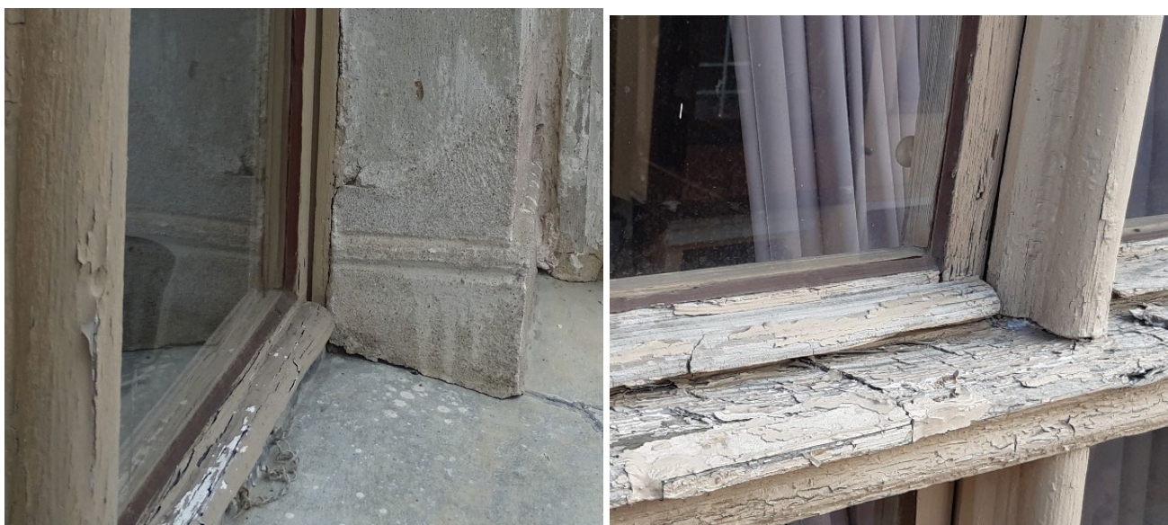
fot 51. Stan historycznej stolarki – fragmenty ościeżnicy i ramy okiennej od strony podwórza (elewacja wschodnia).
