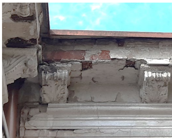
fot 44. Stan okapu dachu i gzymsu koronującego od strony podwórza
