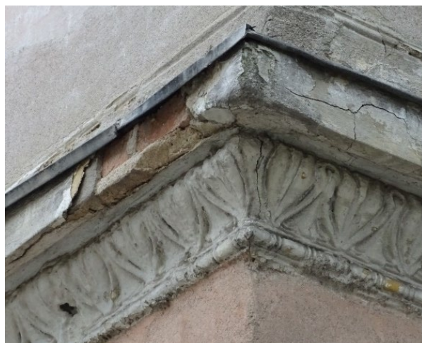
fot 29. Uszkodzenia gzymsu – rozwarstwienie i odspajanie tynków, zniszczone i zdeformowane okapniki.
