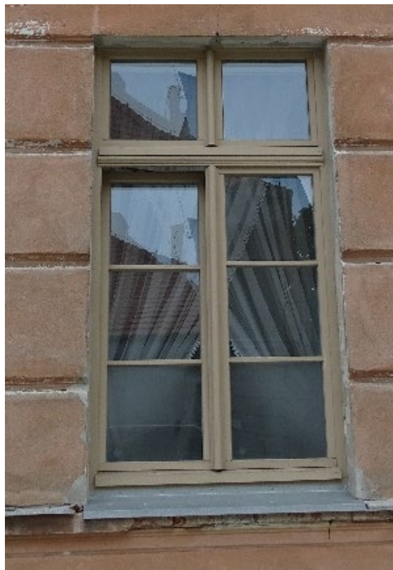
fot 47. Nowe okno drewniane na elewacji wschodniej .
