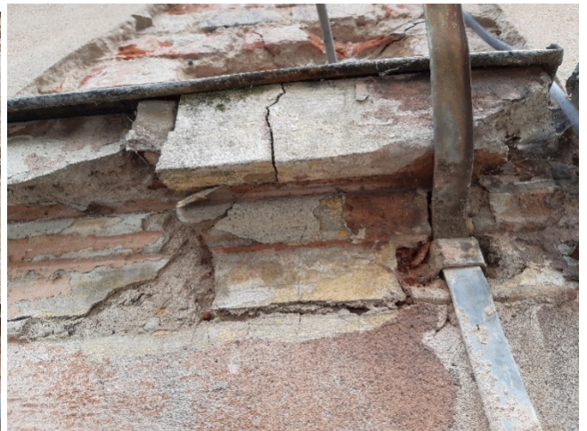
fot 18. Fragmenty elewacji zachodniej - zniszczenia tynków i zamontowane instalacje.
