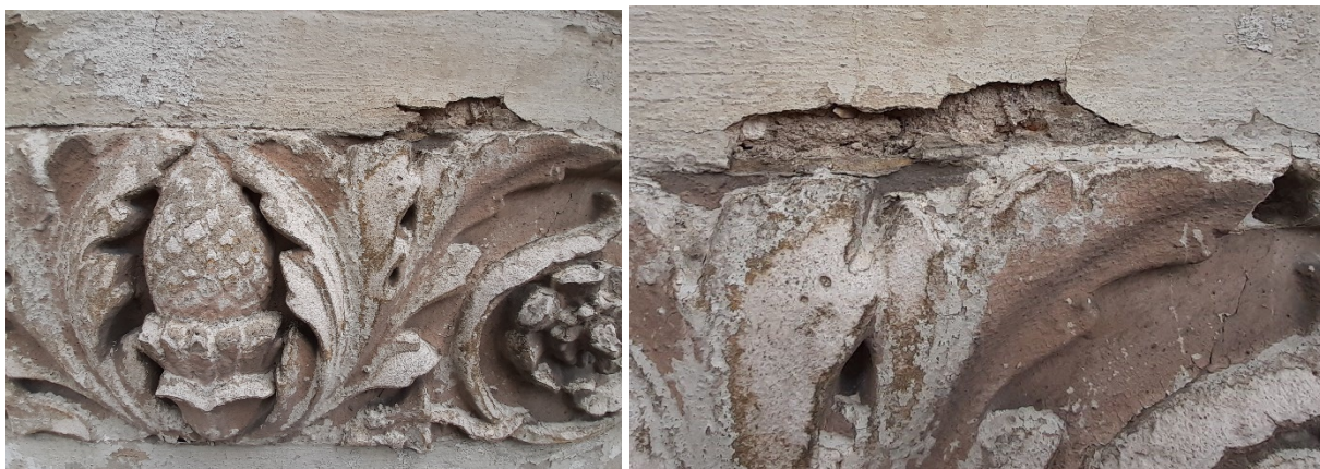
fot 36. Fragmenty płyciny z ornamentem z fryzu podokiennego – zniszczenia detali.
