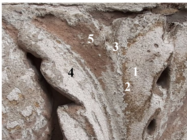
fot 77. Płycina pod oknem środkowym w ryzalicie od strony zachodniej – zaznaczone miejsca odkrywek i pobrania próbek
