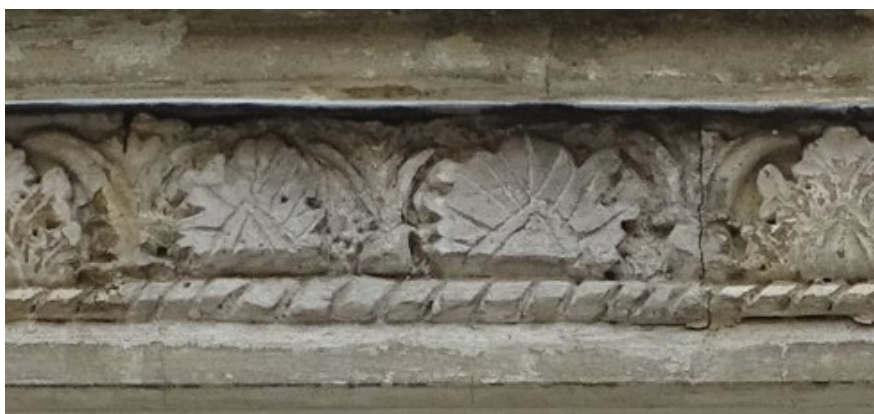
fot 37. Zniekształcone detale fryzu po niefachowym uzupełnieniu – elewacja zachodnia.
