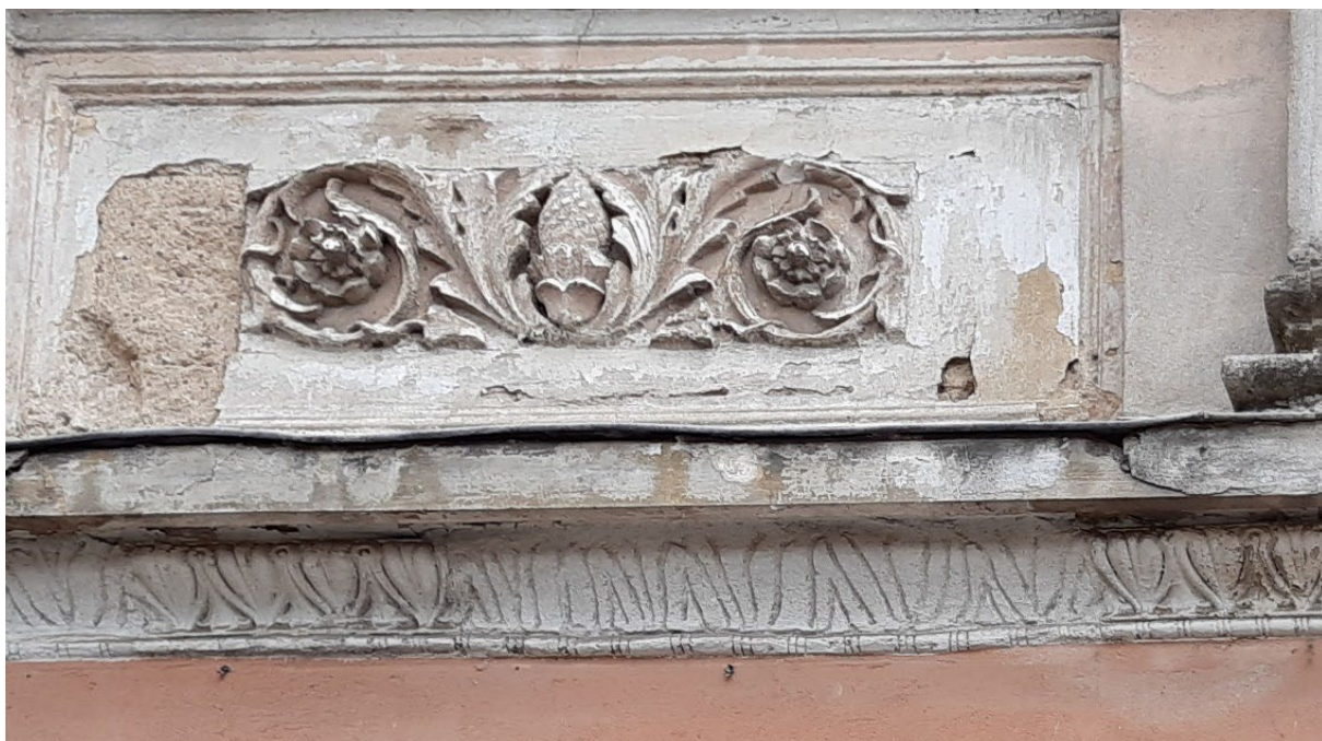
fot 35. Fragment elewacji zachodniej – zniszczenia płyciny podokiennej.
