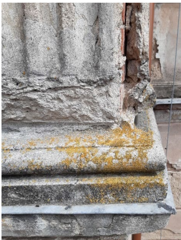
fot 26. Baza pilastra z ryzalitu na elewacji zachodniej – widoczne żółte plamy porostów.
