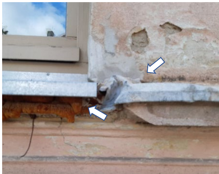
fot 14. Stan elewacji od strony podwórza: wymieniony parapet niechlujnie uszczelniono pianką poliuretanową.
