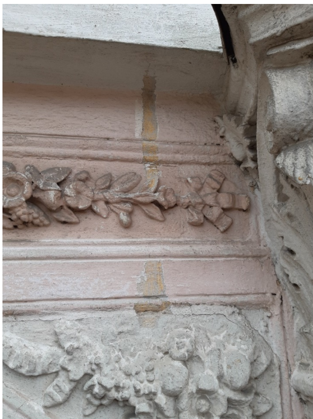
fot 73. Odkrywki wykonane na fryzie ryzalitu od strony zachodniej.
