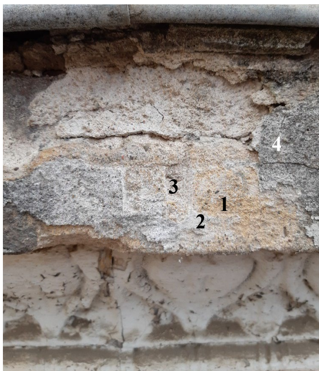
fot 63. Odkrywka na gzymsie elewacji od strony zachodniej – gzyms wykonany z zaprawy i pomalowany na żółto.
