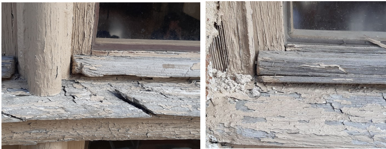
fot 50. Ościeżnica i zewnętrzna rama okna w ryzalicy elewacji zachodniej – widoczne zniszczenia powłok farby sięgające do drewna, które jest zdegradowane i popękane.
