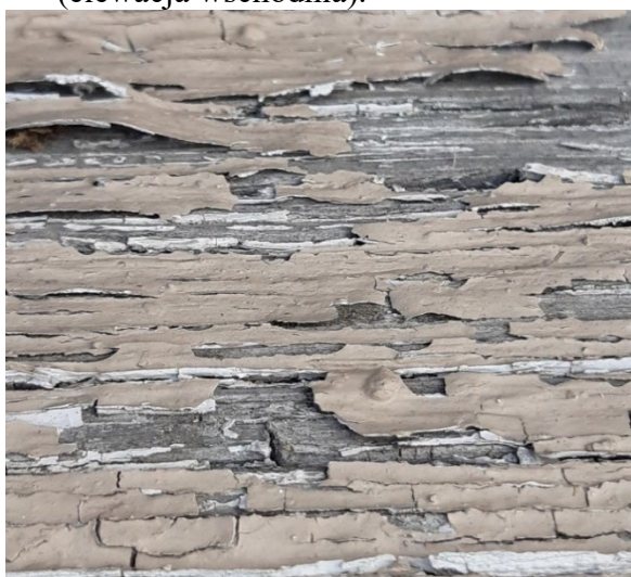
fot 52. Stan drewnianej stolarki okiennej – łuszczące się i odpadające warstwy farby.
