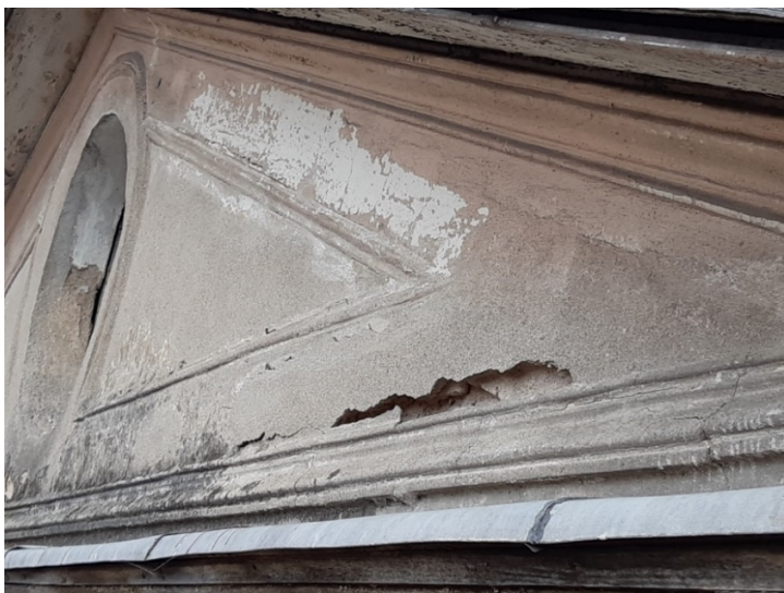
fot 20. Fragment naczółka ryzalitu od strony zachodniej – stan tynków.
