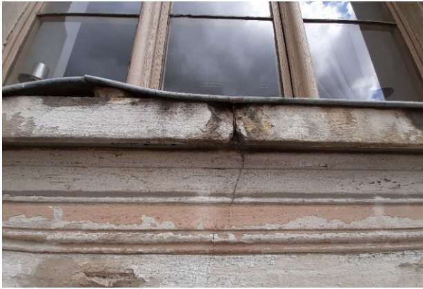
fot 15. Deformacje parapetu okna z II kondygnacji na elewacji zachodniej
