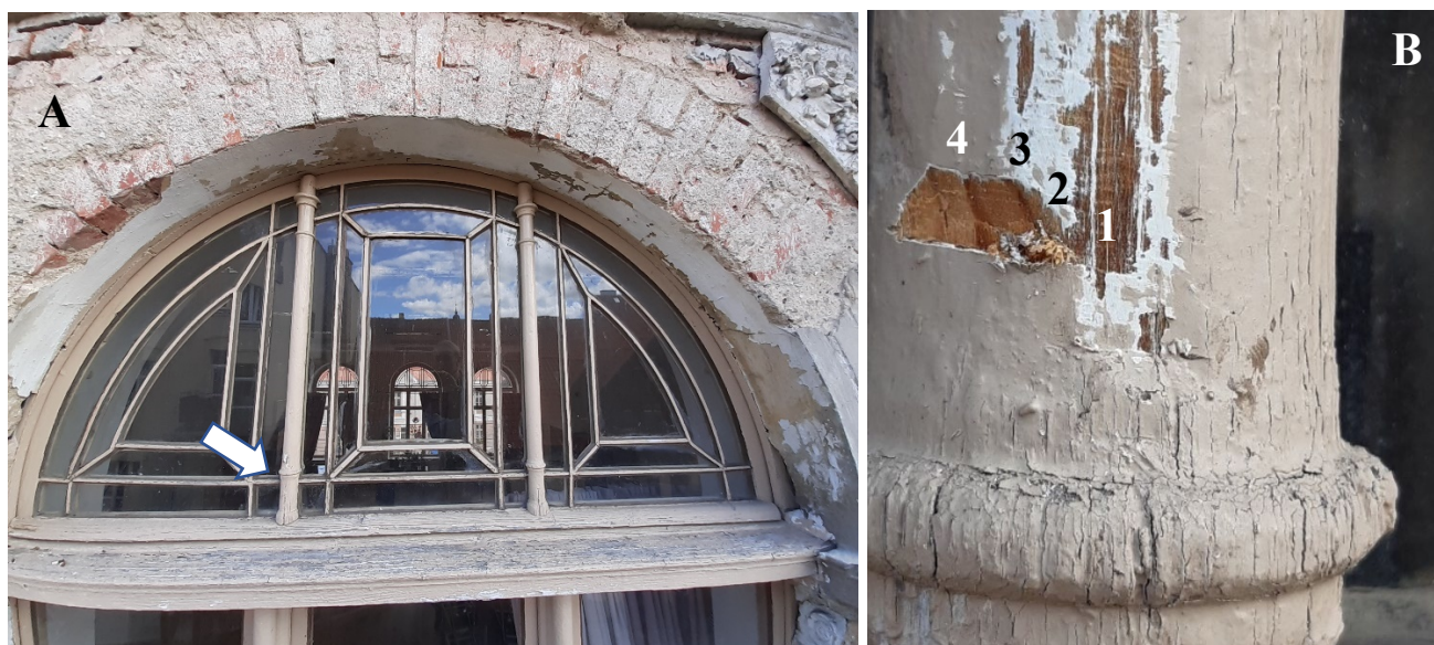
fot 82. Stolarka okienna w ryzalicie na elewacji zachodniej: A – lokalizacja odkrywki; B – miejsce wykonania odkrywki i pobrania próbki 12.
