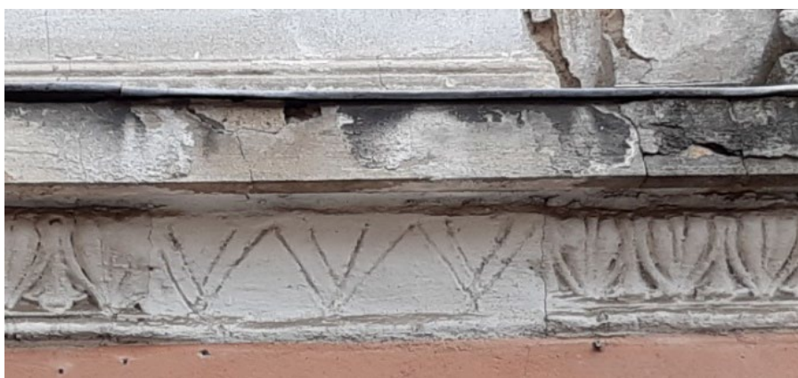
fot 37. Zniekształcone detale fryzu po niefachowym uzupełnieniu – elewacja zachodnia.
