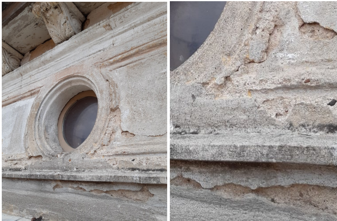
fot 22. Fragment fryzu z okienkami na elewacji zachodniej – widoczne strukturalne zniszczenia tynków.
